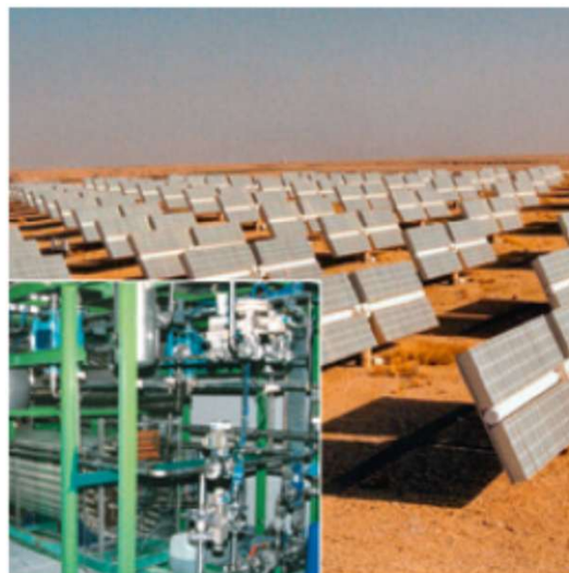
Abbildung 3.7: 350 kW Druckelektrolyseur des Hysolar-Projektes in Riyadh 1)
