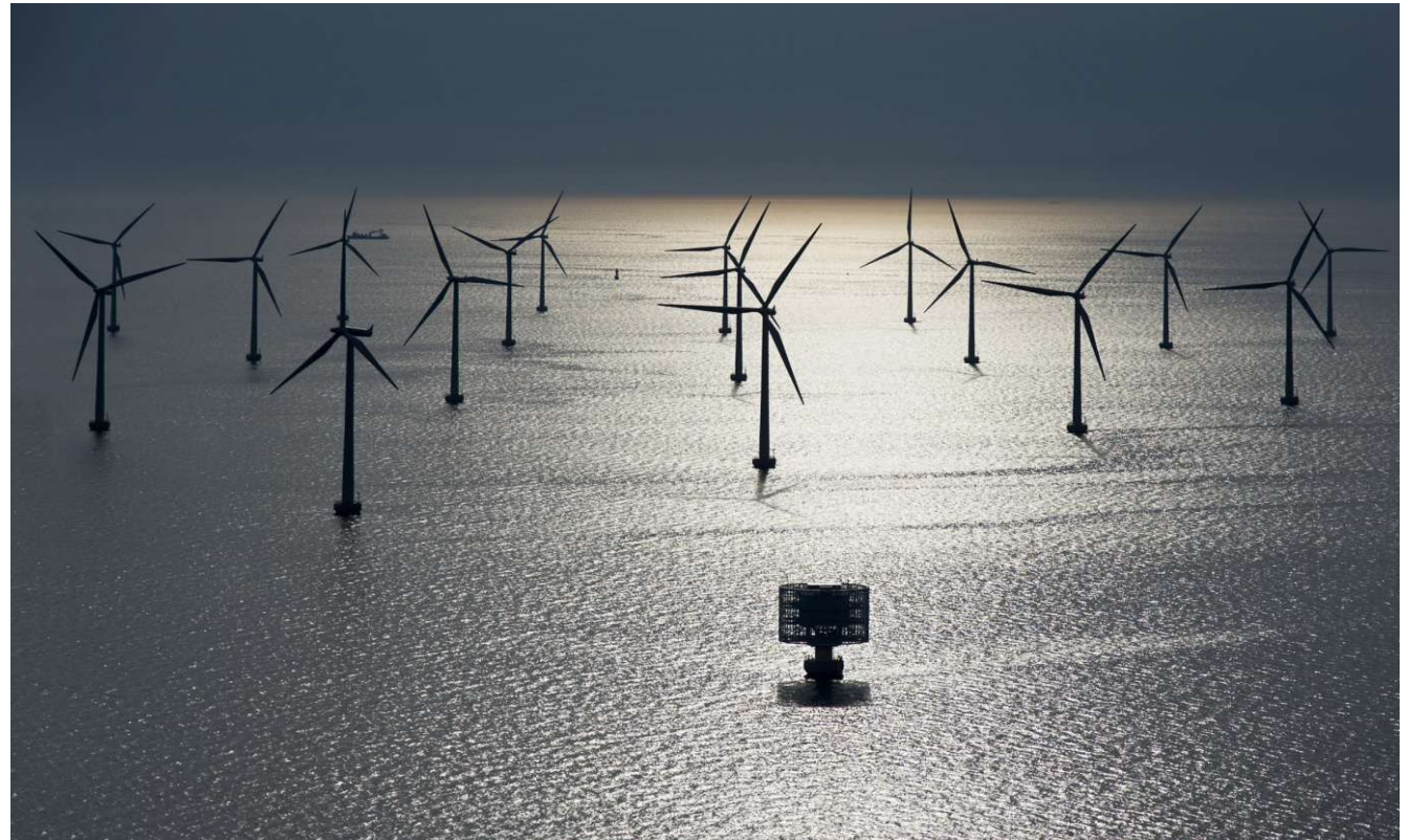
Das Bauwerk vorne ist die Umspannstation Siemens-Pressesbild
