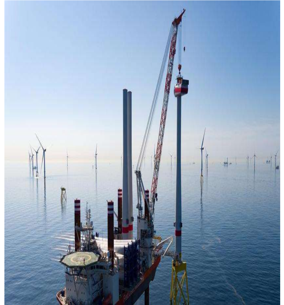
Bild: MDR/Prounen Film - Aufbau einer Offshore-Umspannstation beim Offshore-Windpark Borkum Riffgrund 2
