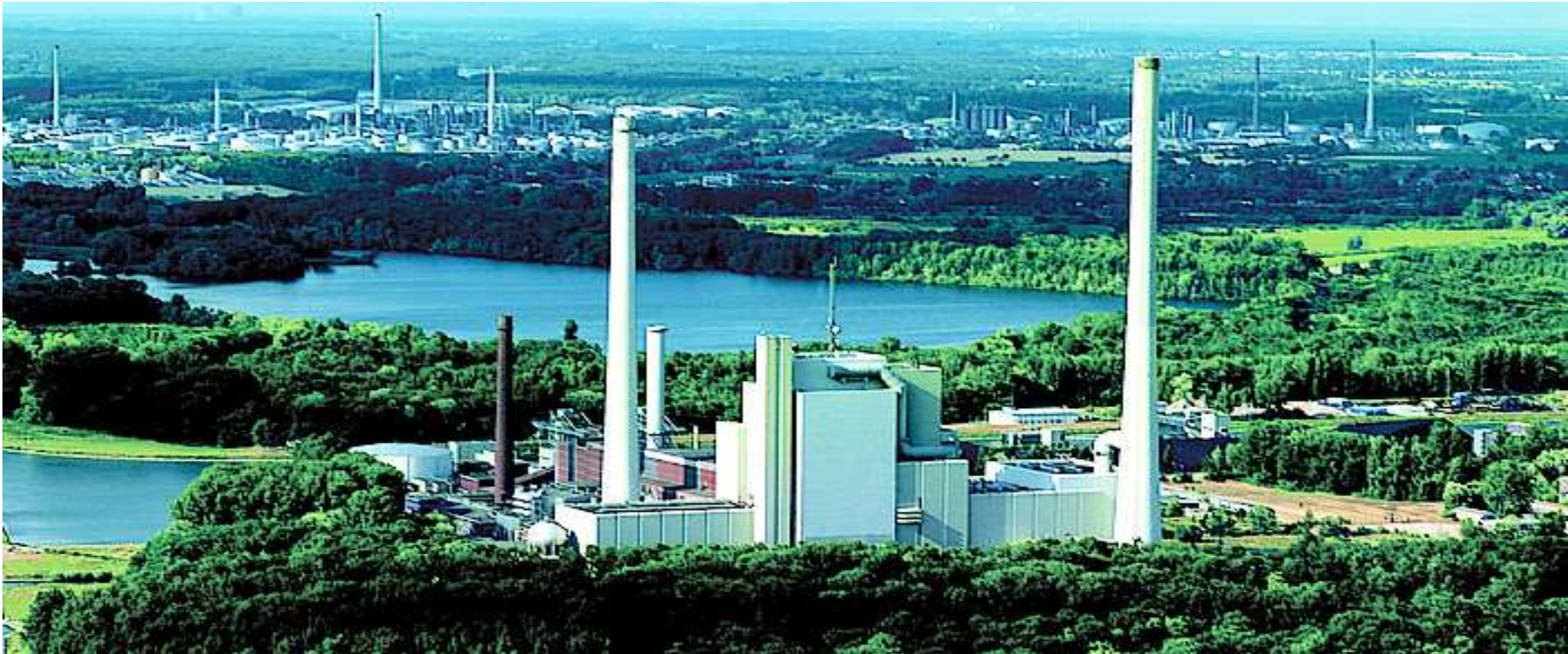
Das Rheinhafen-Dampfkraftwerk Karlsruhe erzeugt Strom und Fernwärme. Quelle: ENBW/Bernd Franck
