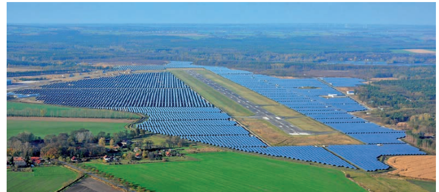
Solarmodule, so weit das Auge reicht, im Neuhardenberger Solarpark
