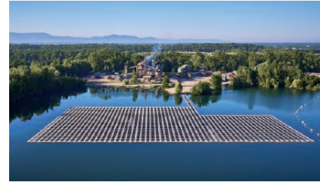
Schwimmendes Kraftwerk bei Renchen (S. 155)
