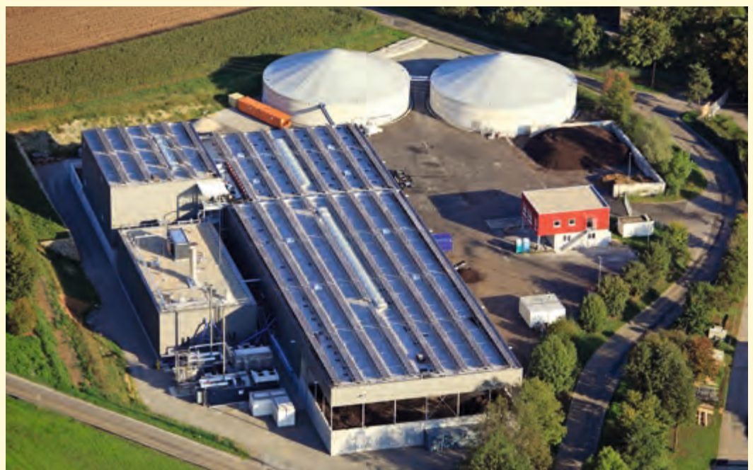
ABB. 5: BIOABFALLVERGÄRUNGSANLAGE DER ABFALLWIRTSCHAFTSGESELLSCHAFT DES REMS-MURRKREISES MBH (AWG) IN BACKNANG-NEUSCHÖNTAL
